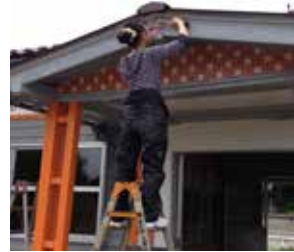
ファサードロゴ取り付け風景
