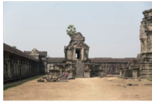
第二回廊内部（崩壊した石材が散在）
