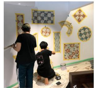
学内で制作したモザイク画をボンドとビスで固定しモルタルで壁面と一体化させる
