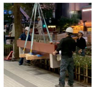
早朝クレーンによる設置 (香林坊丸アトリオ)
