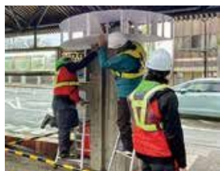
現地での案内サイン試作確認の様子
